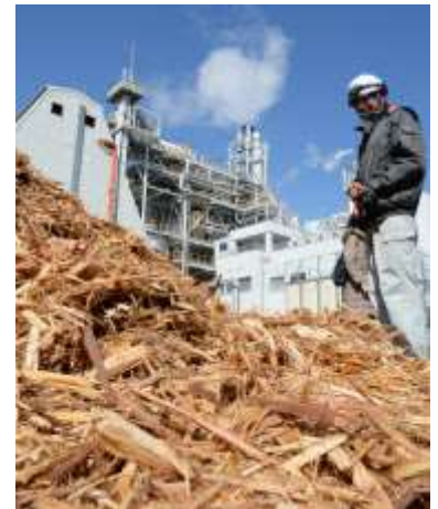
生木や建築廃材などの木材チップを燃料に使うバイオマス発電所（福島県白河市）
