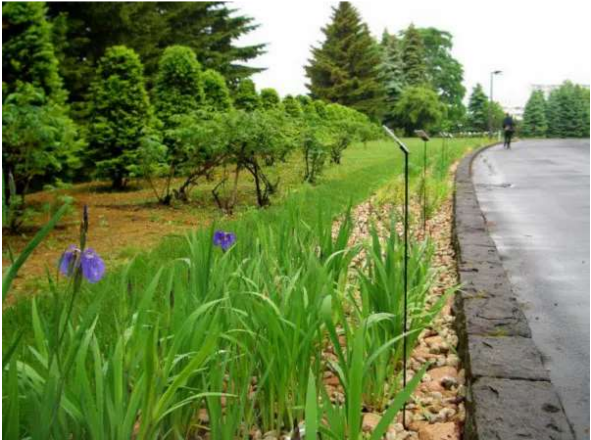
水害対策として雨水を貯留できる花壇の設置を進めている（札幌市）
