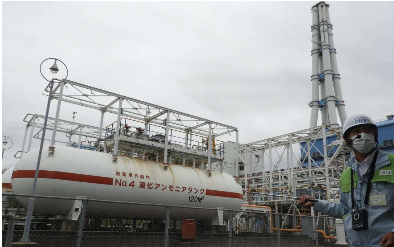
アンモニアをガス化して石炭に混ぜて発電する
