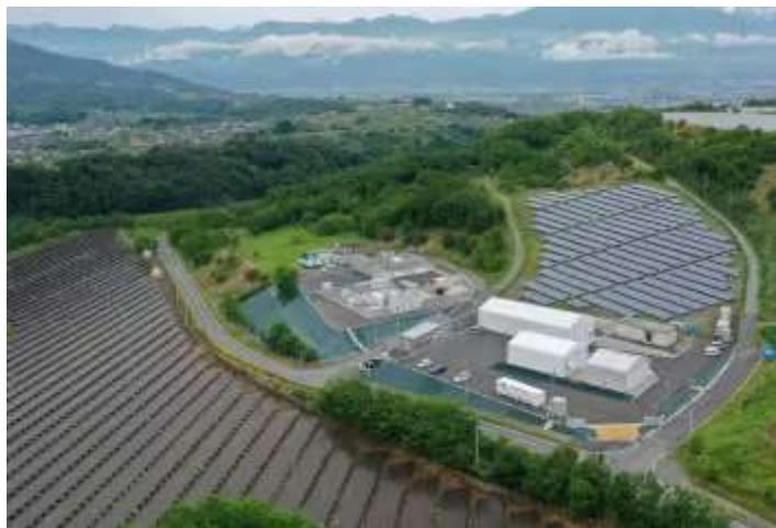
山梨県にある水素製造装置を電力系統に組み込む（山梨県の製造拠点）
