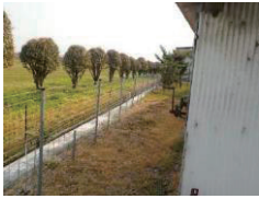
農場侵入防護柵 (飼養衛生管理の強化)
