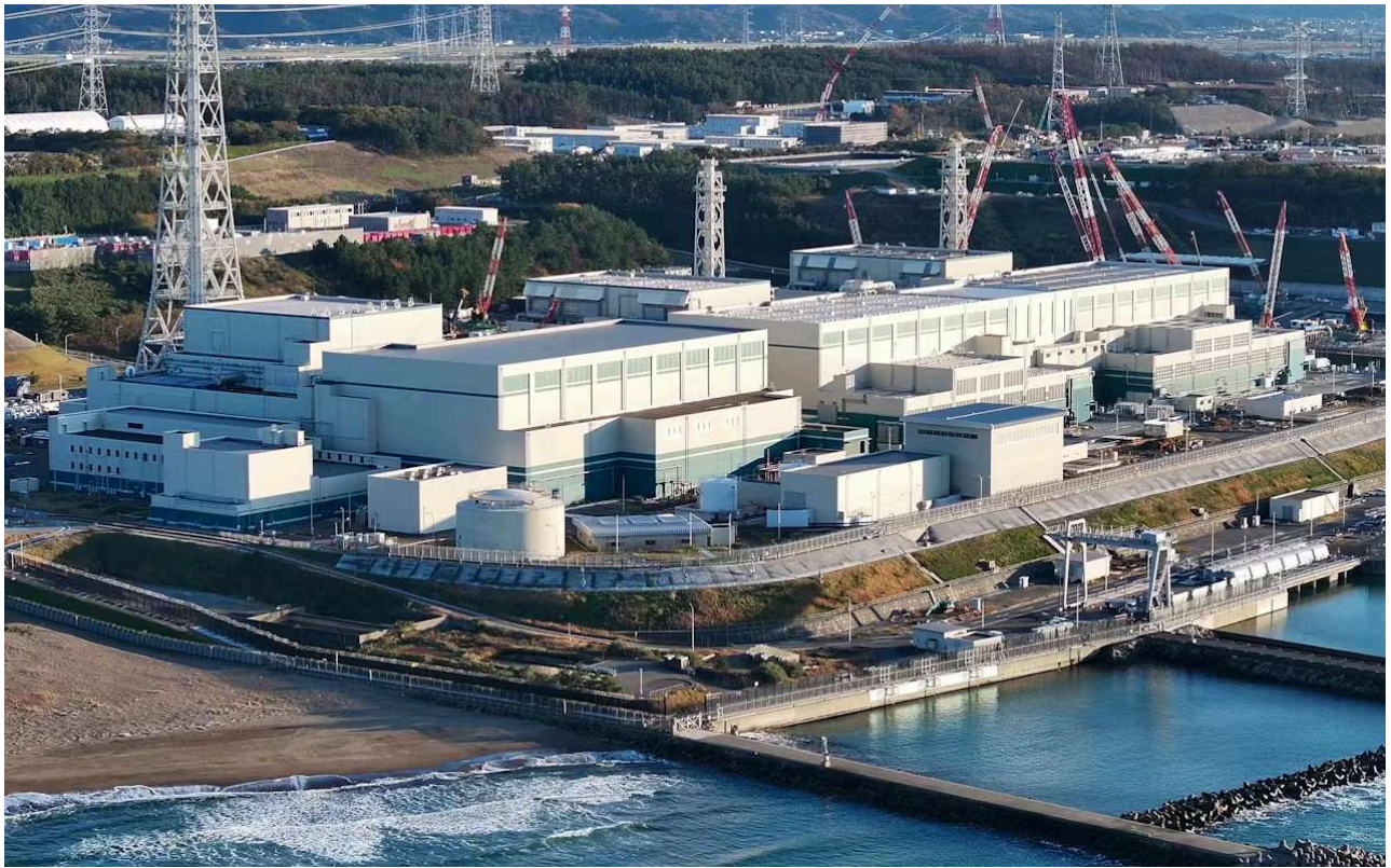
東京電力柏崎刈羽原子力発電所（新潟県）
